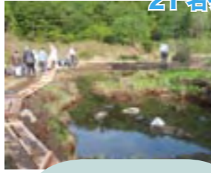
穴のまわりの畔を整え、木道を設置。
