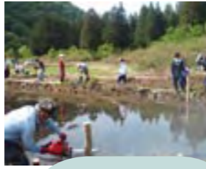
杭を打ち込み、枝を通して土留めをする。
